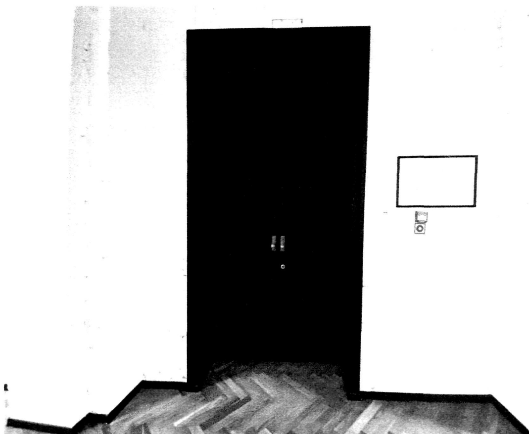
Фото 20. Запасный выход на 2 этаже.
