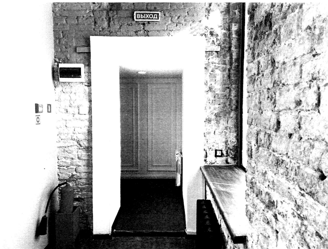
Фото 5. Вид на коридор 1 этажа.
