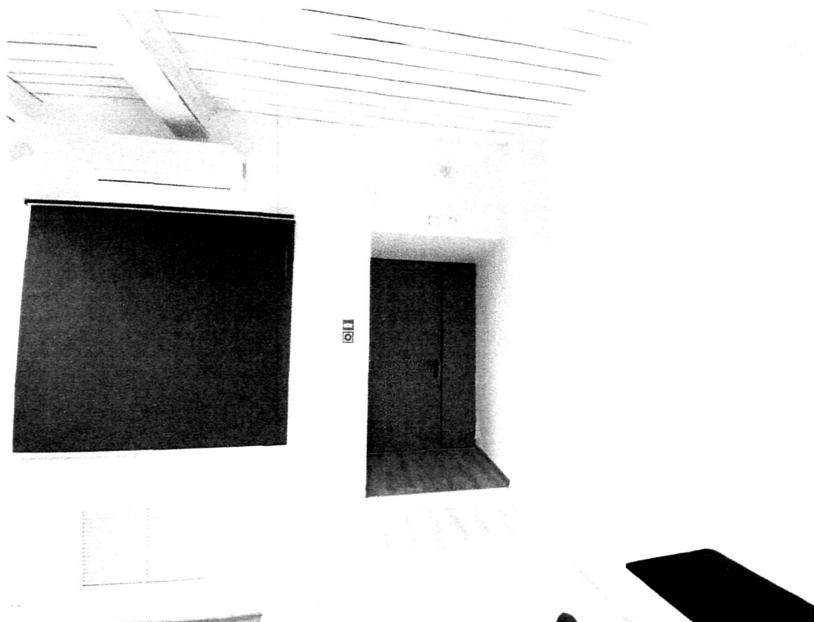
Фото 19. Запасный выход на 1 этаже.
